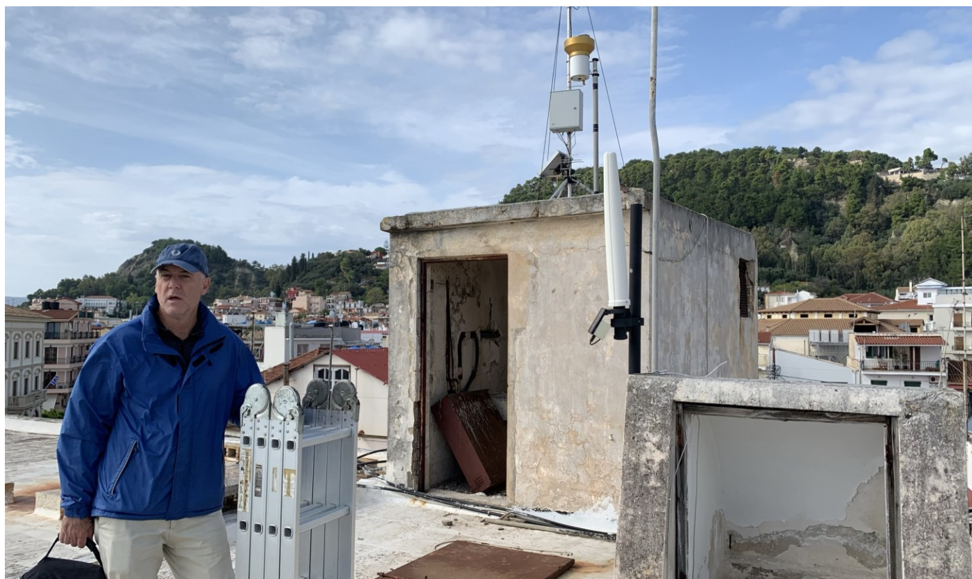
Εικόνα 1.2-1: Απο τις τεχνικές εργασίες στον σταθμό ΖΚΤ-4 στις 26/10/2021.
