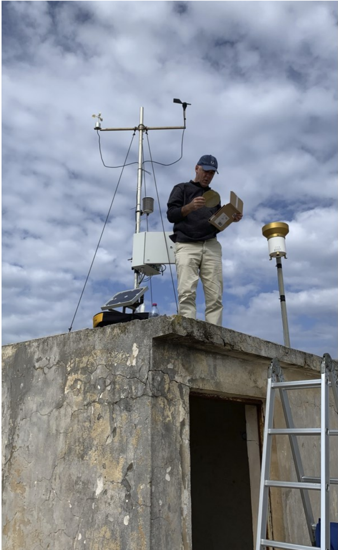
Εικόνα 1.2-5: Απο τις τεχνικές εργασίες στον σταθμό ΖΚΤ-4 στις 26/10/2021.
