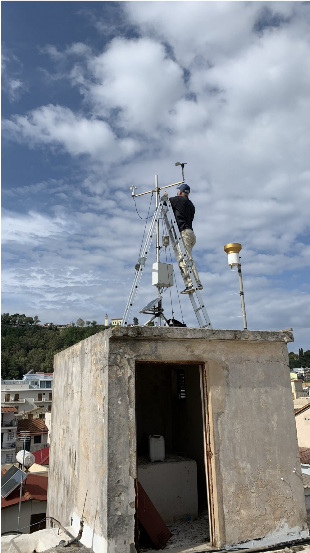
Εικόνα 1.2-6: Απο τις τεχνικές εργασίες στον σταθμό ΖΚΤ-4 στις 26/10/2021.
