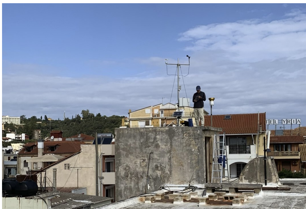
Εικόνα 1.2-3: Απο τις τεχνικές εργασίες στον σταθμό ΖΚΤ-4 στις 26/10/2021.
